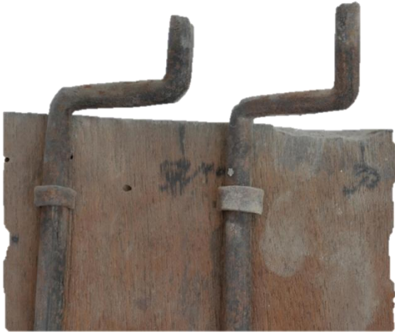
Particolare Catenacciatura dei registri
