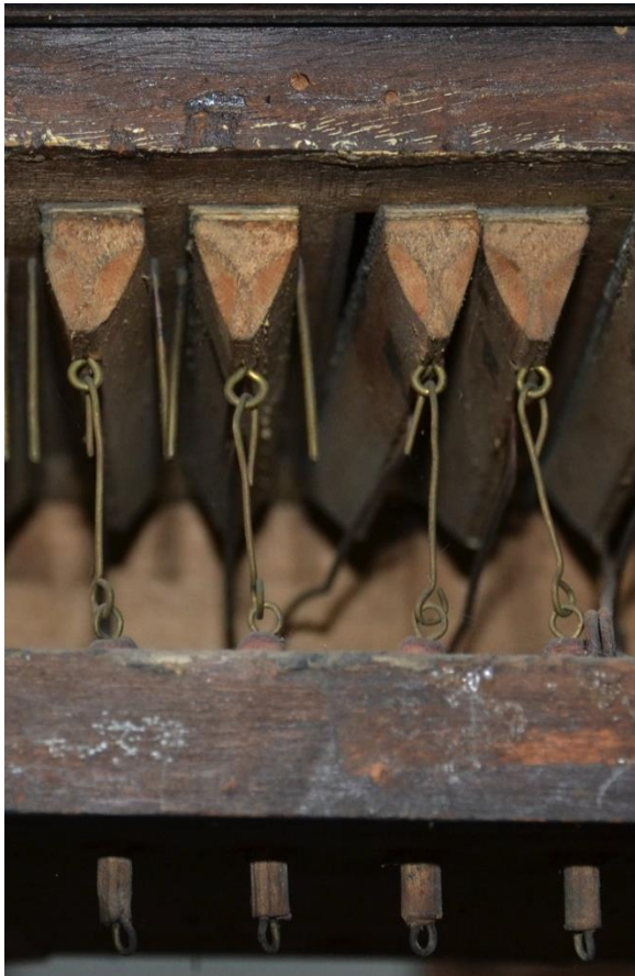
Particolare dei ventilabri prima e dopo il restauro
