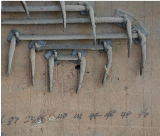
Particolare Catenacciatura del manuale
